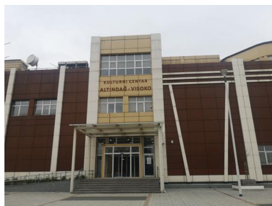
SLIKA 5/6/7 – ZATEČENO STANJE POSTOJEĆIH OBJEKATA (terenski obilazak dana 23.04.2021.)
